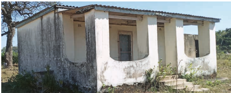
Mütterwartehaus vor der Renovierung, Foto SolidarMed
