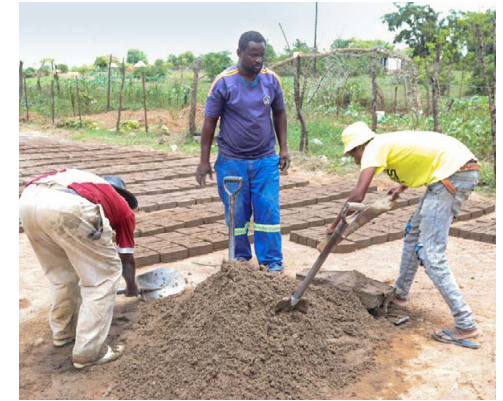
Ziegelproduktion für den Bau des Gesundheitszentrums Foto: SolidarMed
