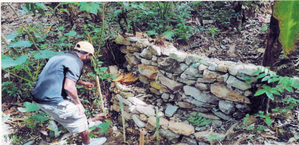
Mit Steinen werden Barrieren errichtet, um den Wasserfluss ins Tal zu verlangsamen und die Erosion zu verhindern.
