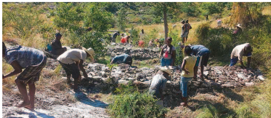
Trockenmauern festigen den Untergrund und schützen vor Erosion.
